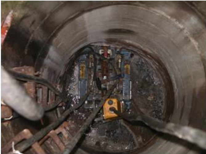
Bild 7: Grundoburst-Maschine im Schacht installiert
