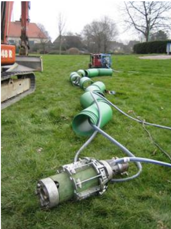
Bild 6: Aufgefädelte PP-Rohre mit Rohrverspanngerät
