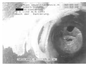
Bsp: Zulauf nach Sanierung mit Janssen-System
