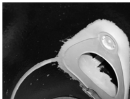
Bsp: Zulauf nach Sanierung mit IMS-System
