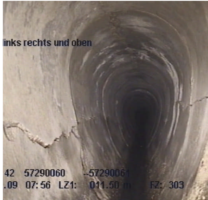
↗ Eiprofil (unbewehrter Beton) mit nach innen eingedrücktem Kämpfer
