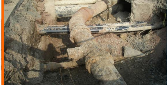
Eine Wasserleitung läuft durch unser Bauwerk und muss verlegt werden
