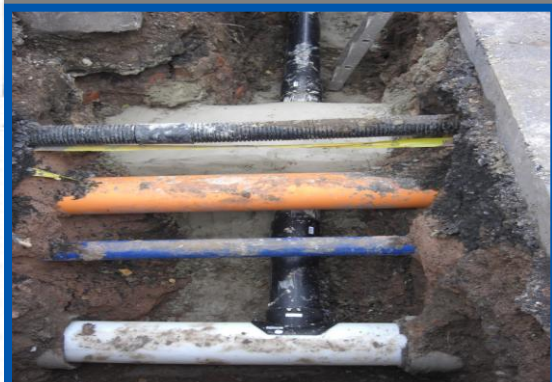
Gas, Wasser, Abwasser und Strom wurden inklusive Hausanschluss erneuert und geordnet
