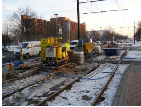
Bild 6 und 7: Niederdruckinjektionen im Bereich der Bahngleise
