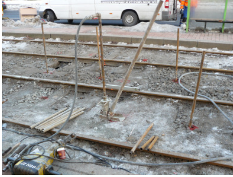
Bild 6 und 7: Niederdruckinjektionen im Bereich der Bahngleise
