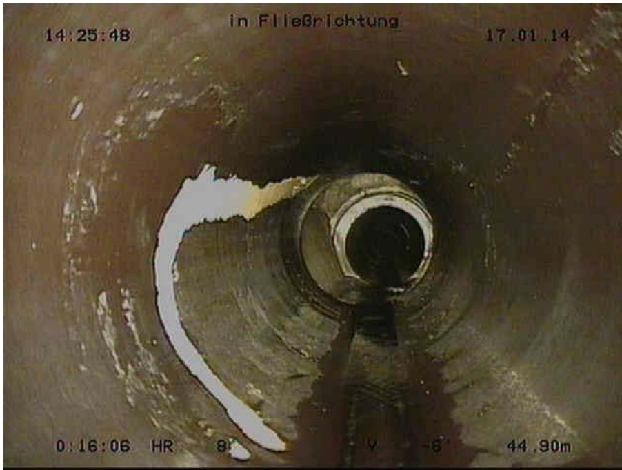
Bild 10: verspalteter Riss
