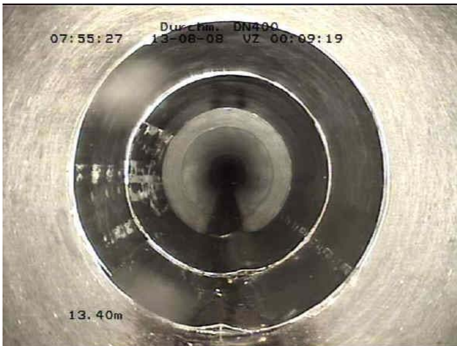
Bild 12: Edelmanschette (verklebt) mit beginnender Aufkantung in der Sohle
