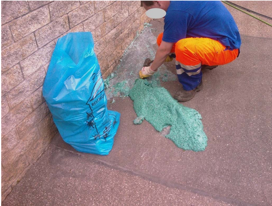
Bild 8: ausgetretenes Injektionsharz
