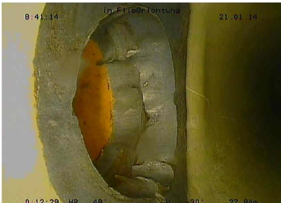
Bild 11: zwei Arbeitsgänge bei Zulaufanbindung mittels Verpressverfahren
