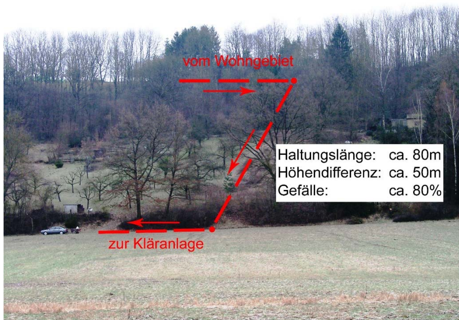
Bild 5: große Höhendifferenz schließt Warmwasserhärtung aus
