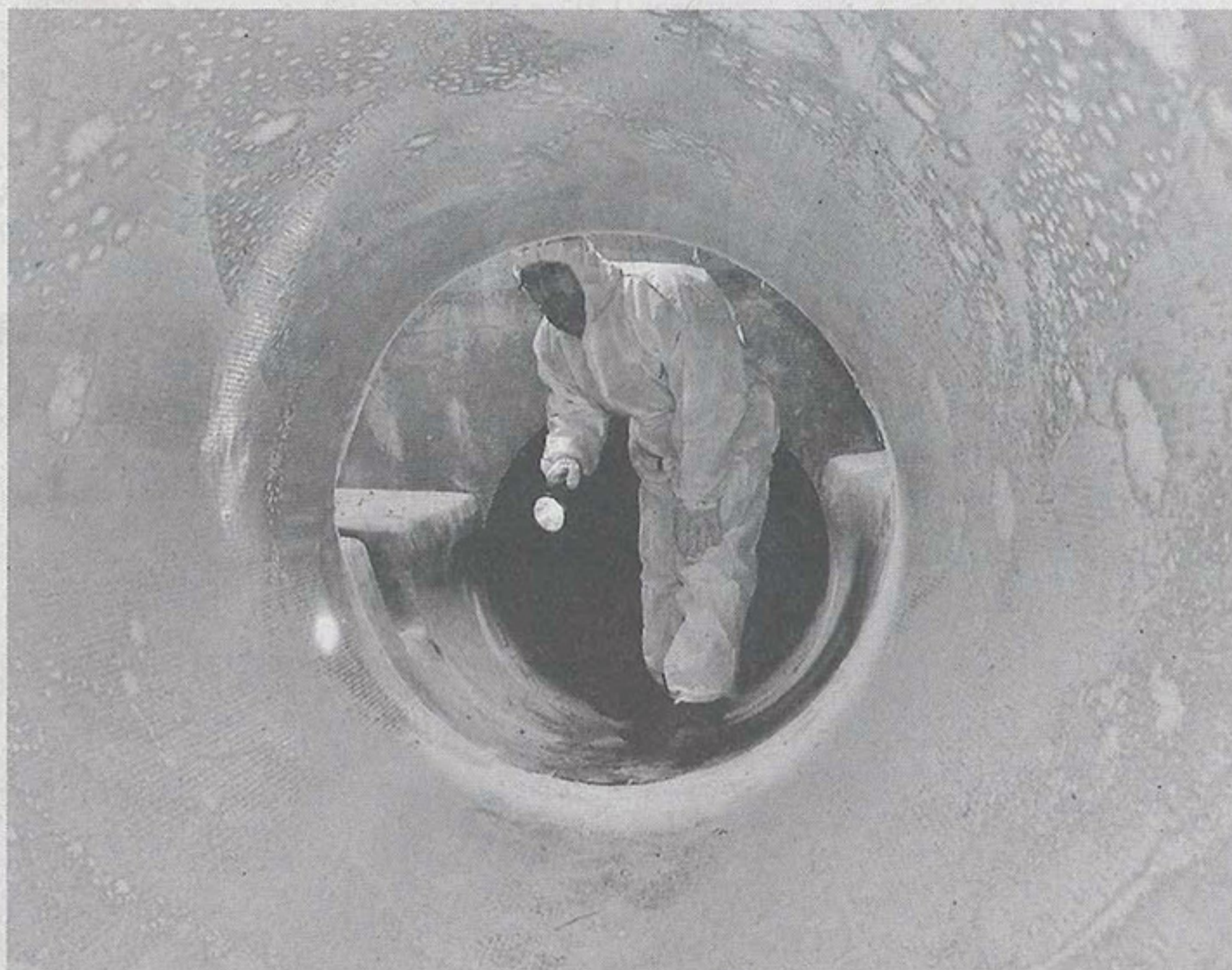
Der 12. Deutsche Schlauchlinertag richtet den Blick auf politische, rechtliche, technische und qualitative Aspekte der Schlauchlinertechnologie. Foto: KMG
