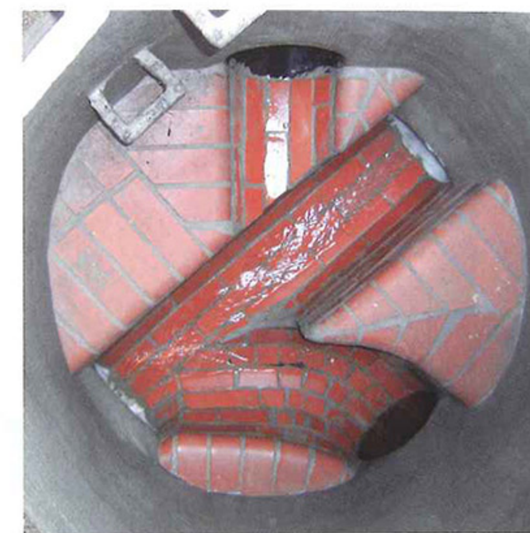
Einsatz von Reparaturverfahren im begehbaren Bereich. | Foto: Vogel Ingenieure
