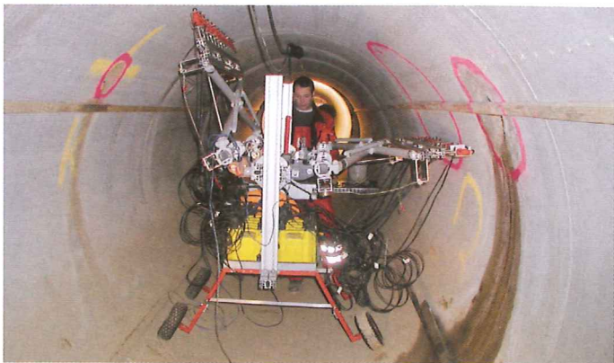
VERMÖGENSWERTE SICHERN: Erfassung des Rohr-Boden-Systems mit innovativer Messtechnik
